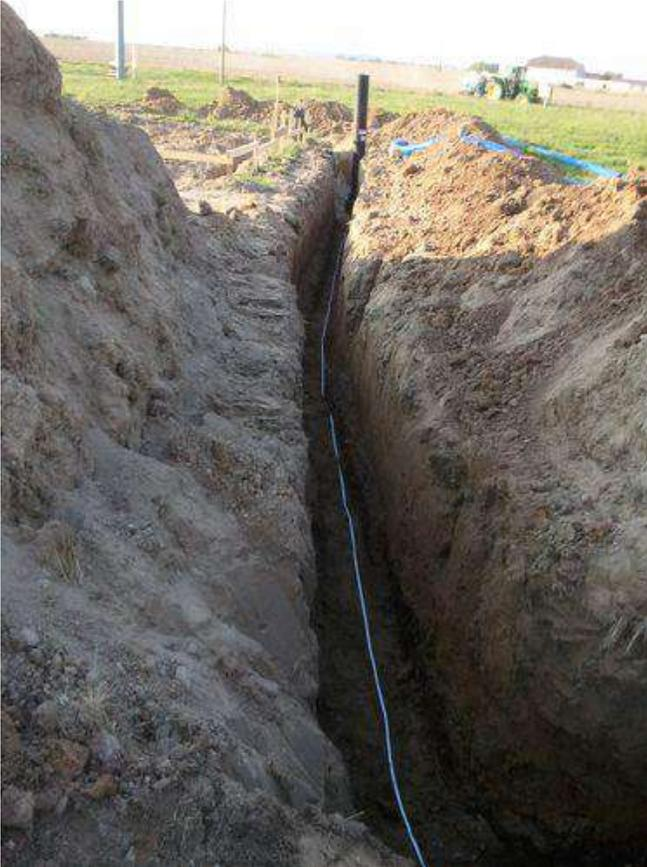
Pose et attache de la boucle de terre à fond de fouille
